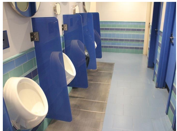
海底世界—男廁所小便斗下設清洗水孔，防止滴尿殘留及異味的產生。
